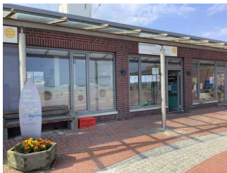
Nebeneingangstür zum Gästekindergarten im Servicegebäude
