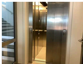
Vorflur im EG zum Aufzug ins Oberdeck
