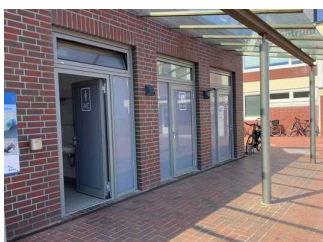
Weg vom Servicegebäude zum öffentlichen WC
