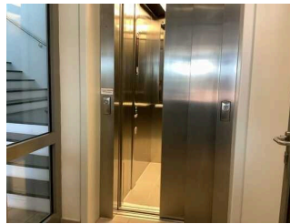
Vorflur im EG zum Aufzug ins Oberdeck
