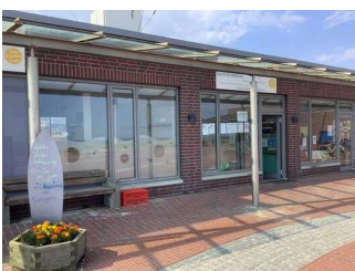
Nebeneingangstür zum Gästekindergarten im Servicegebäude
