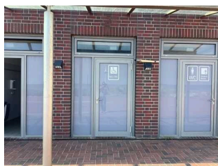
Weg vom Servicegebäude zum öffentlichen WC
