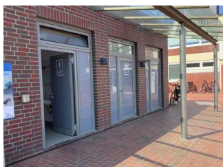
Weg vom Servicegebäude zum öffentlichen WC
