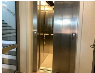
Vorflur im EG zum Aufzug ins Oberdeck
