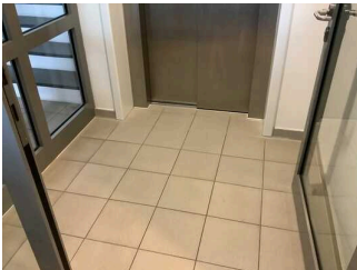
Vorflur im EG zum Aufzug ins Oberdeck
