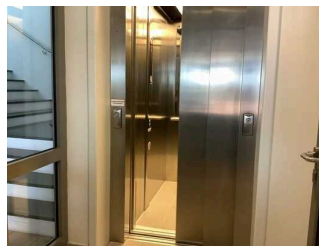
Vorflur im EG zum Aufzug ins Oberdeck
