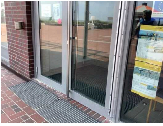
Eingangsbereich zum Oberdeck, Gästekindergarten und Malstudio
