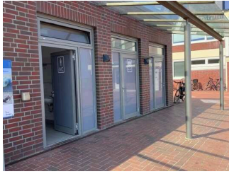
Weg vom Servicegebäude zum öffentlichen WC
