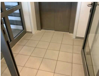
Vorflur im EG zum Aufzug ins Oberdeck
