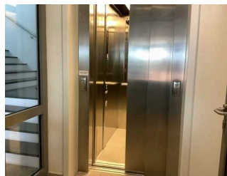
Vorflur im EG zum Aufzug ins Oberdeck
