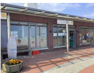
Nebeneingangstür zum Gästekindergarten im Servicegebäude
