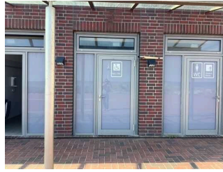
Weg vom Servicegebäude zum öffentlichen WC
