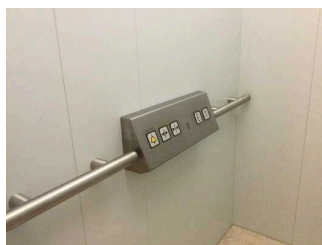
Aufzug zwischen Wellnessbereich und Saunabereich
