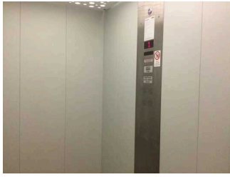
Aufzug zwischen Wellnessbereich und Saunabereich
