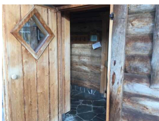
Windfang zwischen Außenanlage und Sauna in Blockhütte
