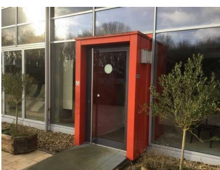
Außentür zur Schleuse zwischen Innenbereich und Außenbereich
