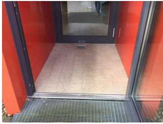
Schleuse zwischen Innenbereich Sauna und Außenbereich Sauna
