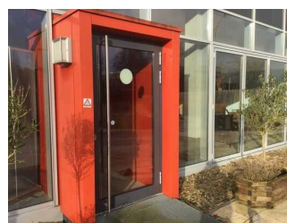
Außentür zur Schleuse zwischen Innenbereich und Außenbereich
