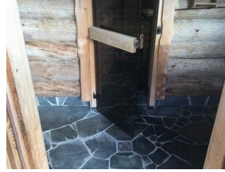
Windfang zwischen Außenanlage und Sauna in Blockhütte
