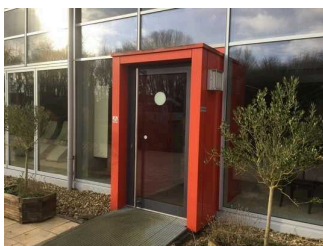
Außentür zur Schleuse zwischen Innenbereich und Außenbereich
