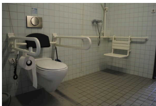
Dusche und Wc für Menschen mit Behinderung im Bereich Umkleiden Schwimmbad
