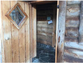
Windfang zwischen Außenanlage und Sauna in Blockhütte
