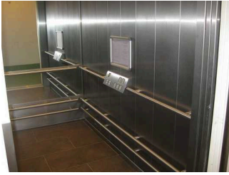
Aufzugskabine und die horizontal angeordneten Bedienelemente
