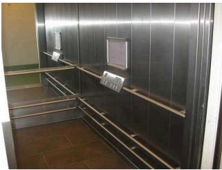
Aufzugskabine und die horizontal angeordneten Bedienelemente
