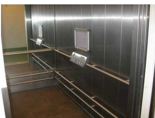
Aufzugskabine und die horizontal angeordneten Bedienelemente
