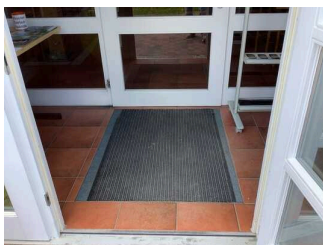
Windfangtür Eingang Hauptgebäude / Café
