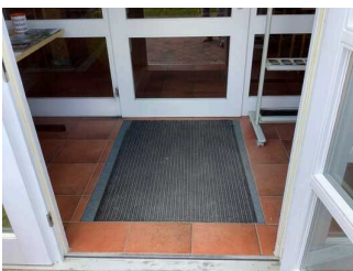
Eingang Hauptgebäude / Café
