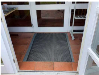
Windfangtür Eingang Hauptgebäude / Café
