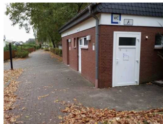
Wegfläche vor WC
