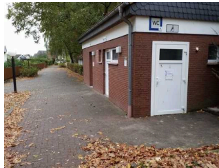
Wegfläche vor WC
