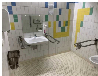
WC Dusche im Umkleidebereich
