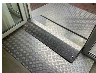
Rampe über die Türschwelle
