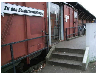
Treppenaufgang zum Haupteingang
