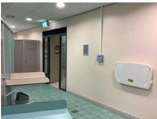
Tür zur Schwimmhalle auf dem Weg von Umkleide für Menschen mit Behinderung
