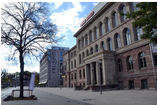
Gehweg vom Bahnhof zum Eingang
