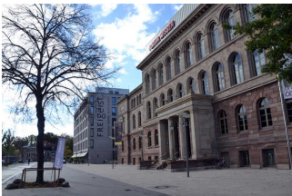
Gehweg vom Bahnhof zum Eingang
