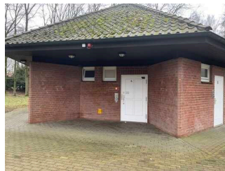
Öffentliches WC am Parkplatz P2
