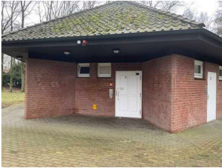
Öffentliches WC am Parkplatz P2
