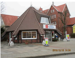
TI-Döse Außenansicht: weiße Tür links = öffentliches WC; rechts Haupteingang
