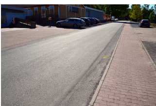
Weg vom Parkplatz zum Eingang
