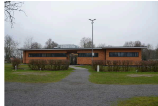
Sanitärgebäude S1 (Sternengarten)
