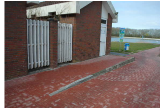
Eingang WC und Weg außen vom Parkplatz zum Spielplatz und Toilette für Menschen mit Behinderung
