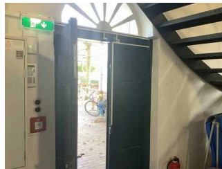
Eingang Sielhafenmuseum und barrierefreier Eingang Nationalparkhaus
