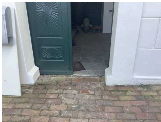
Eingang Sielhafenmuseum und barrierefreier Eingang Nationalparkhaus
