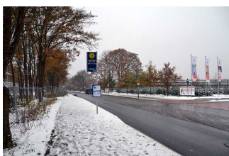
Bushaltestelle Wasserwelt Langenhagen
