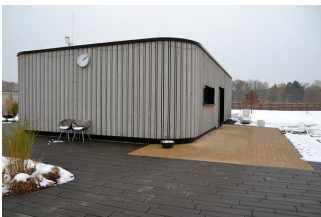
Räume der Kaminsauna
