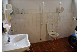
Sanitärraum in Freibad- Umkleidekabine
