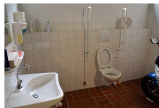
Freibad Umkleidekabine Rollstuhl
