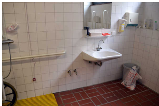
Sanitärraum in Freibad- Umkleidekabine
