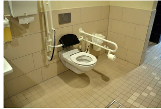
Dusche/WC in Umkleidekabine
