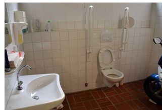
Freibad Umkleidekabine Rollstuhl
