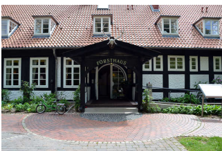
Stufen am Eingang Forsthaus
