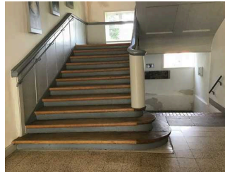
Treppe an der Kasse vom EG bis 1. OG
