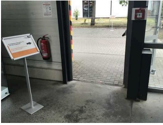
Tür aus Halle 2: Durchgang zu den Hallen 3–5
