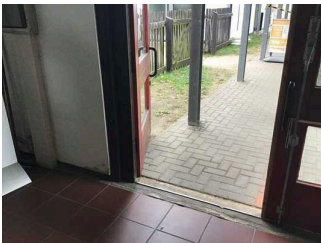
Tür aus Halle 5 Richtung Eingangshalle/ Cafeteria/ Museumshop
