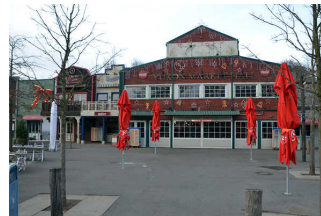
Betonweg Yukon Bay
