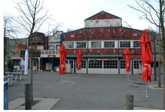
Betonweg Yukon Bay
