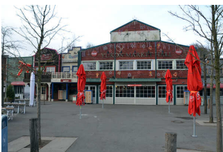
Yukon Market Hall mit WC
