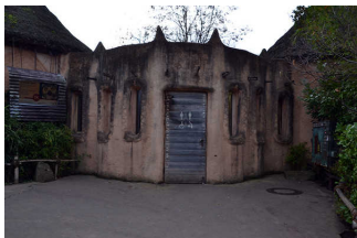
Tür WC-Anlage Sambesi
