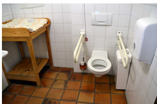
Behinderten-WC am Gasthaus Meyer (außen rechts)
