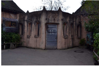
Tür WC-Anlage Sambesi
