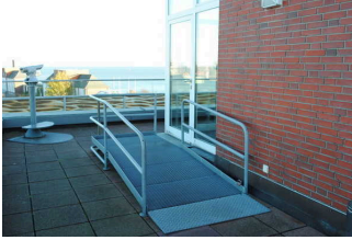
Rampe aussen zur Panorama-Terrasse
