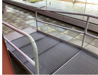
Rampe aussen zur Panorama-Terrasse
