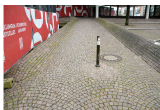
Weg von Bushaltestelle und Parkplätzen zum Haupteingang
