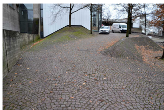
Weg von Bushaltestelle und Parkplätzen zum Haupteingang
