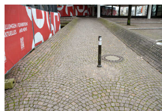
Weg von Bushaltestelle und Parkplätzen zum Haupteingang
