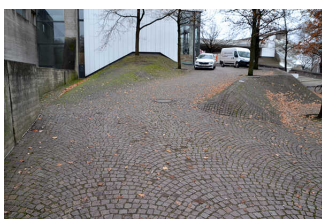
Weg von Bushaltestelle und Parkplätzen zum Haupteingang
