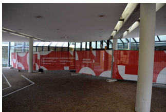
Haupteingang EG (geschlossen)
