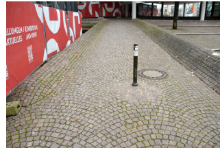
Weg von Bushaltestelle und Parkplätzen zum Haupteingang
