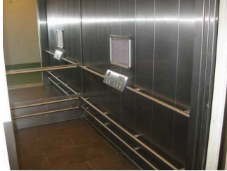
Aufzugskabine und die horizontal angeordneten Bedienelemente
