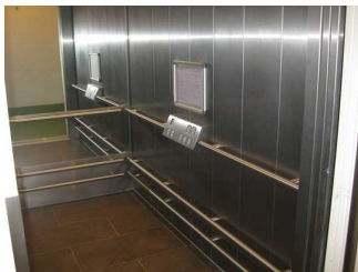
Aufzugskabine und die horizontal angeordneten Bedienelemente
