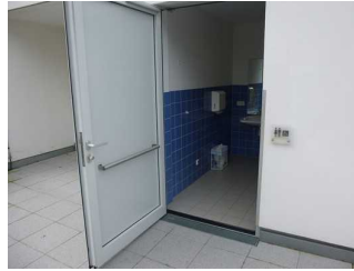
Tür zum WC auf der Dachterrasse.
