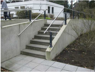
Treppe zum Eingang.
