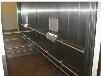
Aufzugskabine und die horizontal angeordneten Bedienelemente
