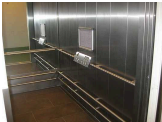
Aufzugskabine und die horizontal angeordneten Bedienelemente
