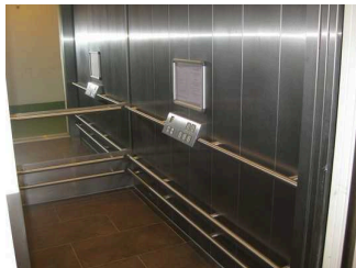
Aufzugskabine und die horizontal angeordneten Bedienelemente
