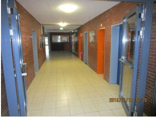
Flur zum Tagesraum 3
