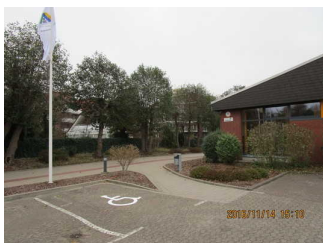
Parkplatz und Weg zum Eingang
