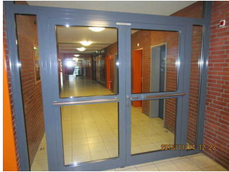
Flurtür 1 Richtung Tagesraum 3
