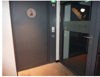
Tür zum barrierefreien WC Spa-Bereich
