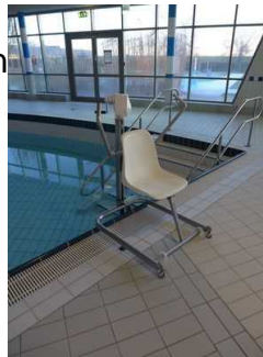
Beckenlift am Hauptschwimmbecken
