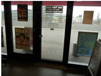
Tür zum Ticketshop // Kasse große EWE Arena
