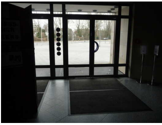
Eingangsbereich / Türen Kongresshalle
