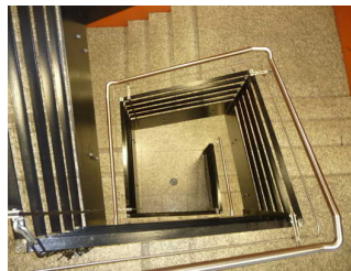
Treppe in der Kongresshalle vom Foyer zur Garderobe (UG.) und zum Foyer 1.OG/1.Rang
