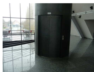
Aufzug in der Kongresshalle vom EG zur Garderobe / WC für Menschen mit Behinderung und ins 1. OG
