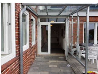
Weg außen zur Eingangstür Schwedenhaus
