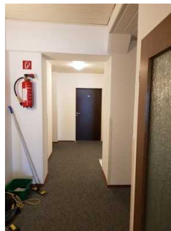
Rampe von Rezeption aus zu den Zimmer 35+36
