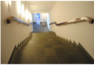
Treppe zwischen Kassenebene / Eingang und Wasserebene
