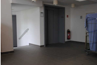
Raum vor dem Aufzug
