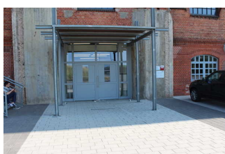
Eingangsbereich der Gebläsehalle
