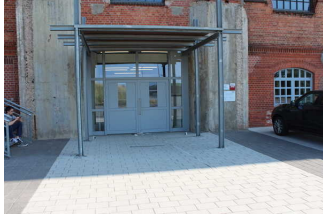
Eingangsbereich der Gebläsehalle
